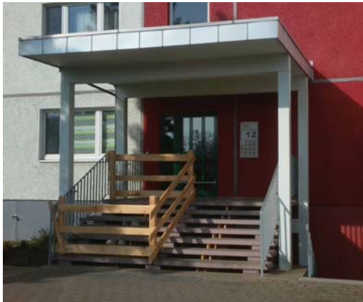
Bestand- teilweise gesperrt
